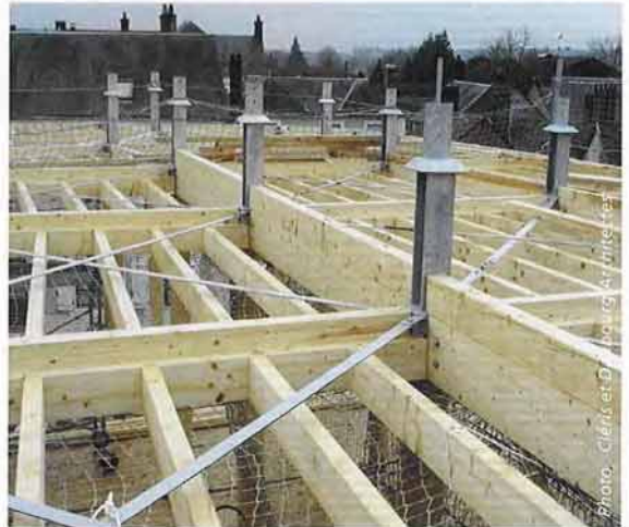
Charpente de la toiture.
