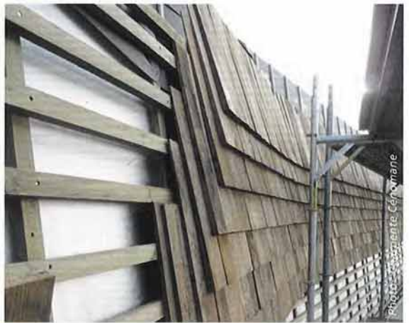
Mise en œuvre des bardeaux.
