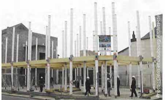
Pose de la charpente primaire.
