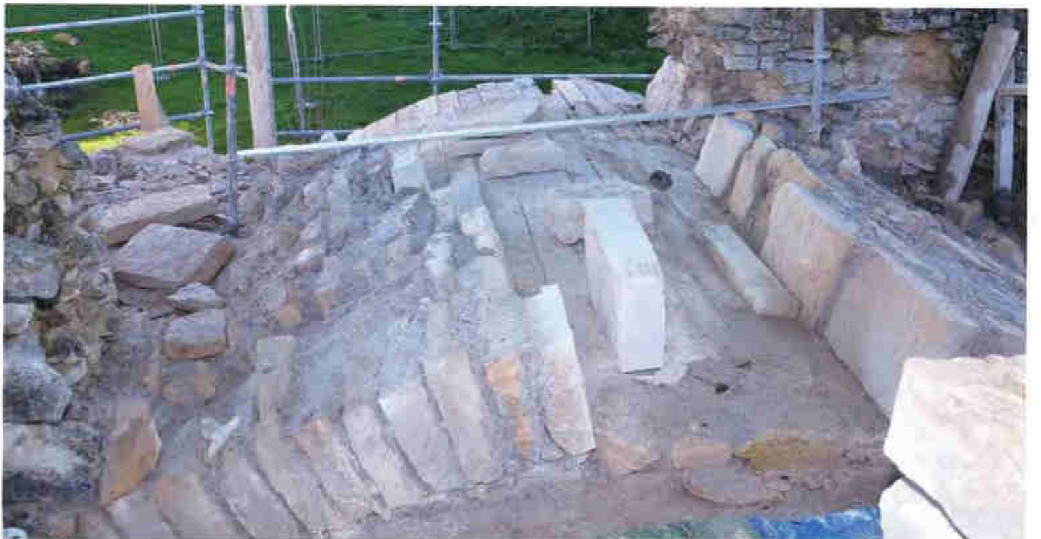
Après la réalisation des voûtes des ravelins, les murs latéraux en maçonnerie de pierre vont être montés afin de faire reposer les passerelles menant au château.
